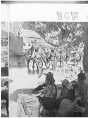
(26) 写真「マリベレスの街を前進してバタンに迫る我が小行李隊の弾薬補給」、『大東亜写真戦記』監修・大本営陸軍報道部、1943年
