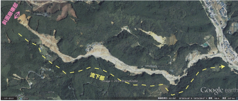
A 熊野酸性岩類地帯の代表的な崩壊-土石流 （那智勝浦町的那智川支流金山谷川-図1④） 中規模の斜面崩壊であるが、発生した土石流は途中の溪床の旧土石流堆積物を巻き込んで大規模化し、非常に長距離流下し、途中の二つの集落と那智川への合流部正面にあった集落を破壊した。
