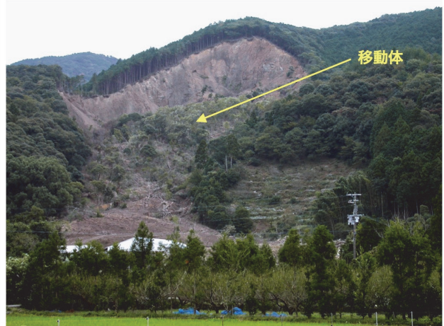
音無川層群（伏菟野）崩壊地 風化泥岩が流下しながら細片化して強い粘度の移動体となり、直下に厚く残留して流下せず。
