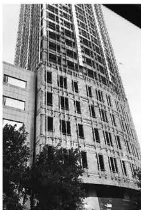
工事が止まった高層ビル、 2019.8.26筆者撮影
