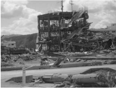
図30 防災庁舎（3・22撮影）
