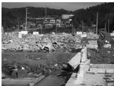
図54 家々の基礎の解体
